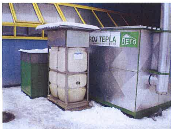
Obr. 9 - Provizorní kotelna na LTO.
