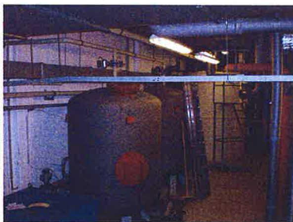
Obr. 6 - Filtry bazénové vody
