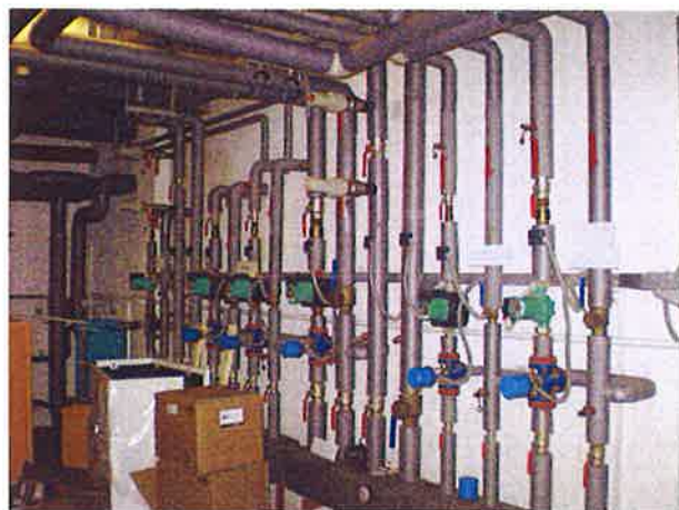
Obr. 4 - Rozdělovač a sběrač topného systému
